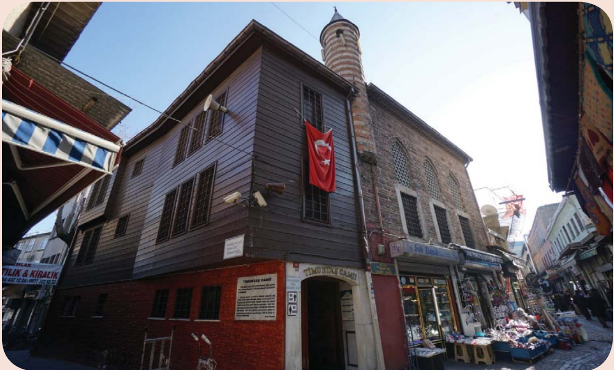
Demirtaş Mahallesi'ne adını veren Demirtaş –Timurtaş Camii
