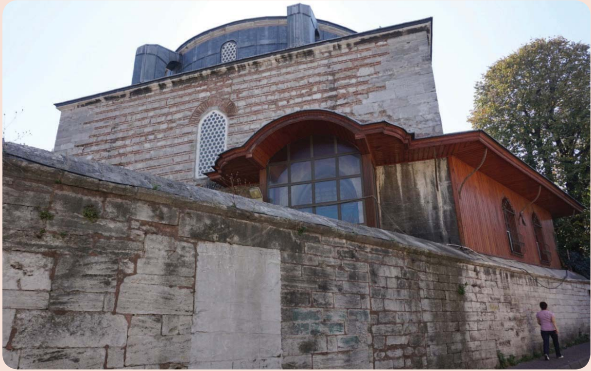
Günümüzde Cerrahpaşa Mahallesi sınırlarında kalan ve Haseki Mahallesi'ne adını veren Haseki Sultan Camii
