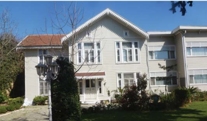
Baltalimanı Sahil Sarayı Selamlığının Bahçesindeki Misafirhane
