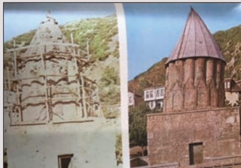
Şekil 13: 1964 Onarımları Öncesi Türbenin Durumu (Yılmaz Önge, "Konya-Akşehir-Seyyid Mahmud Hayran Türbesinin Restorasyonu", Rölöve ve Restorasyon Dergisi , Sayı 2, Ankara 1975.)
